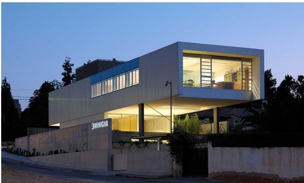
La imagen del edificio acabado viene definida por su condición formal ya descrita y por la apuesta por un único material, el aluminio, como revestimiento exterior. Este material se instala según un particular sistema de fijación que permite realizar un revestimiento continuo sin solución de continuidad.
